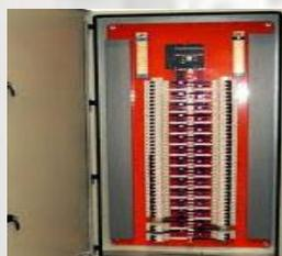
De acordo com a NBR IEC 60050 (826), quadro de distribuição é o "equipamento elétrico destinado a receber energia elétrica através de uma ou mais alimentações, e distribuí-la a um ou mais circuitos, podendo também desempenhar funções de proteção, seccionamento, controle e/ou medição." Um quadro de distribuição pode ser entendido como o "coração" de uma instalação elétrica, já que distribui energia elétrica por toda edificação.
