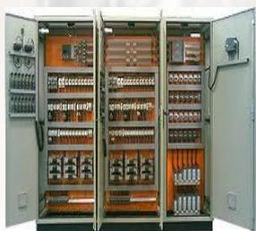
Conhecido pela sigla **CCM**, é um sistema de manobra e comando de motores elétricos de baixa tensão (até 1000 volts) ou de média tensão (acima de 1000 volts).
